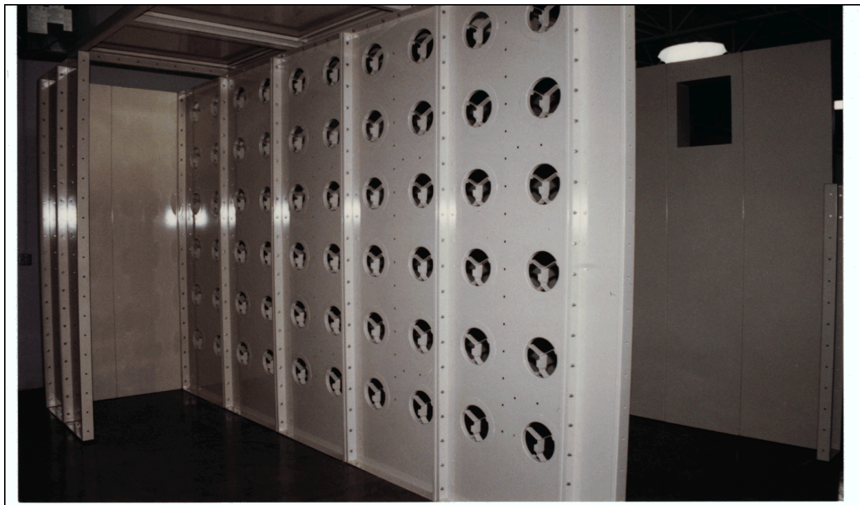
Figura 3 Vista de los paneles armados para el caso de un filtro final montado independientemente.
